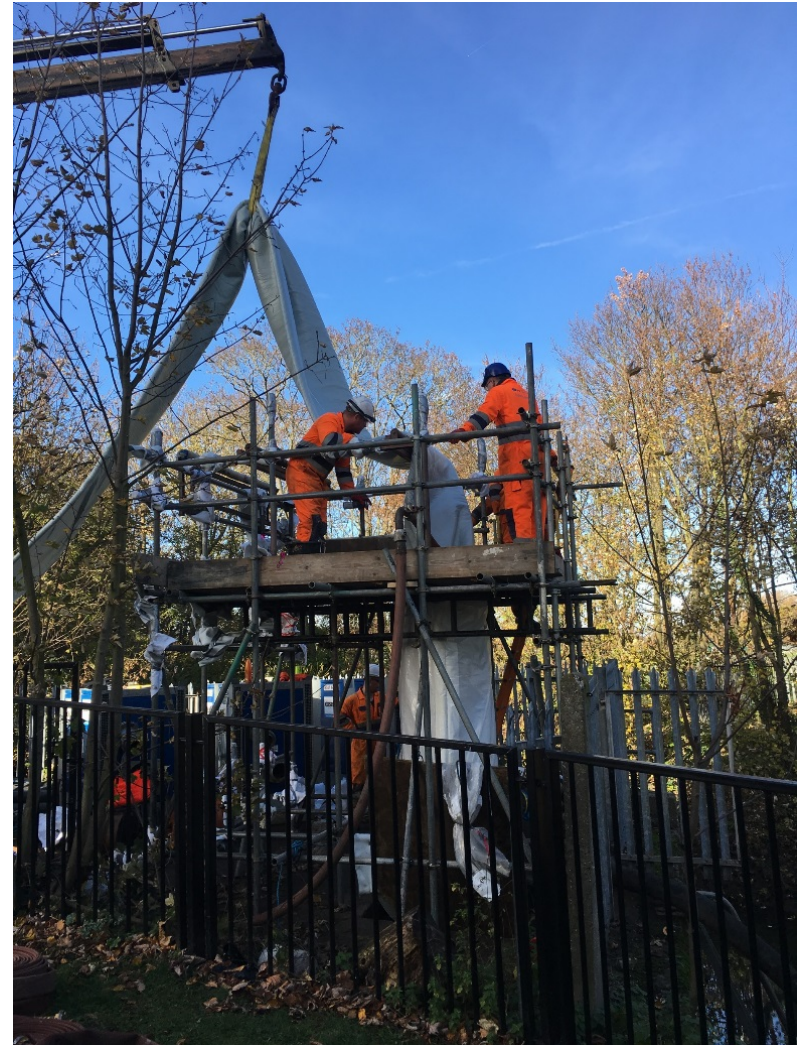
CSO Lining works
